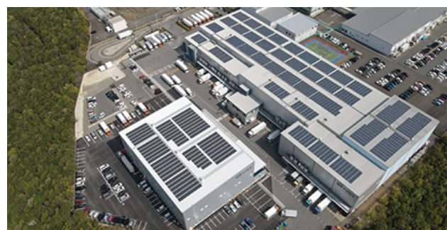
春日井物流センターに設置した太陽光発電システム
