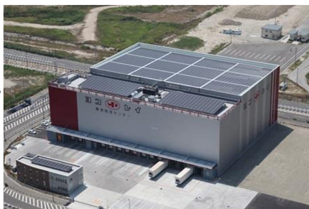
写真：近畿フローズンマザー物流センター
